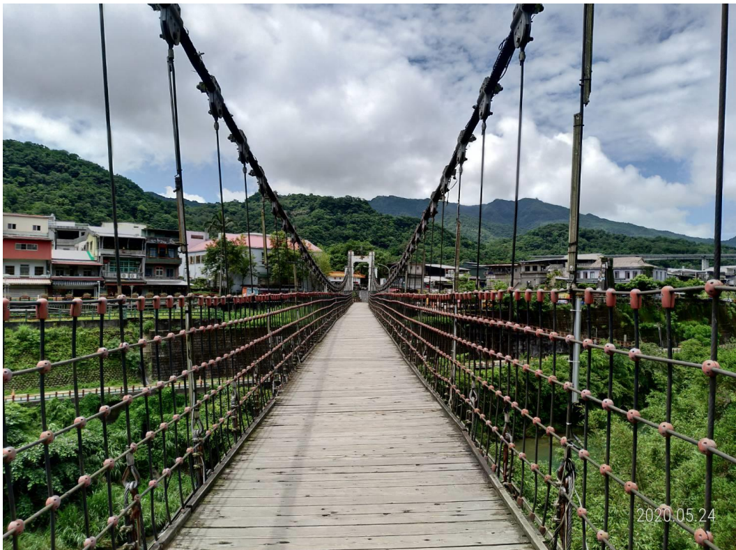
圖五 新北市平溪區靜安吊橋風景區
