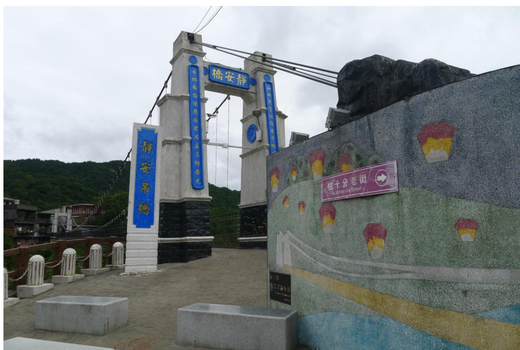
圖五 新北市平溪區靜安吊橋風景區
